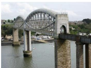
ロイヤル・アルバード橋(右写真)：鉄道橋で、レンズ状トラス橋(弓ツル・ガーダー橋とも言う)。主径間は 138.9m の2径間。
