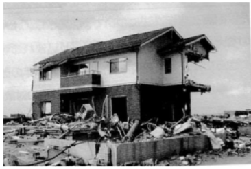
津波の被害で残っている木造建築
