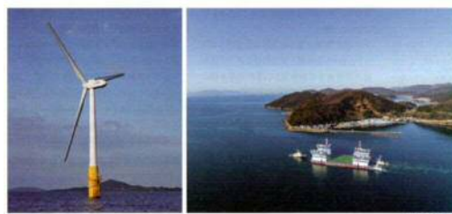
図11 戸田建設は浮体式風車向けに超低コストの仕組みを構築 戸田建設が以前から進めてきた長崎県五島市沖での浮体式風車を引いた電力発電の実証事業の様子(左)。独自開発したスパー型の浮体と2016年3月から2MW級の風車(右)が海上に組みあがって、実証運転中だ。同社は2016年5月に市川町と結盟で、環境省の支援を受けて浮体式風車実証事業を進めている。
