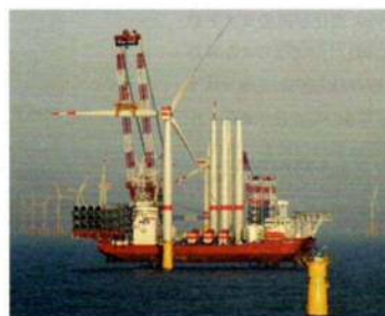
図7 据え付け用SEP船も大型化 丸紅などが出資する英Seajacks InternationalのSEP船「Scylla号」。船は自航式で1500トン規模。14MW級の風車数基を一度に搬送することができ、2021年には台湾の洋上発電プロジェクトでの設置作業に携わる予定である。(写真: 丸紅)
