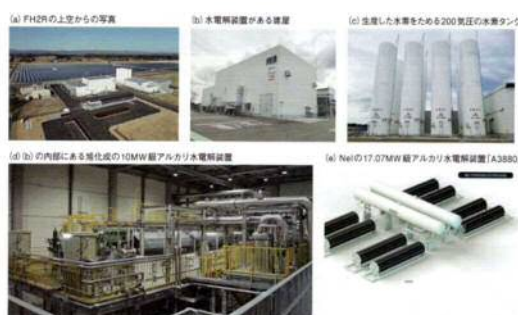
図10 2020年内限定「世界最大」の国内グリーン水素製造システム 福島県浪江町で2020年7月に本格稼働した太陽光発電と水電解装置によるグリーン水素生産施設「福島水素エネルギー研究フィールド（FH2R）」に、旭化成が200気圧の水素タンク、水電解装置は旭化成の10MW級アルカリ水電解装置を導入し、最大1200Nm 3 /時（108kg/時）の水素を生産可能である。装置は世界最大で、2021年にもこれを大きく超える規模のシステムが海外で稼働する見込み（a）～（e）はNEDO、（b）、（c）は旭化成、（d）は旭化成、（e）はノルウェーHydrogenPro
