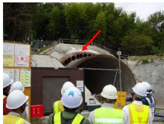
図2 トンネル上部のパイプルーフ
