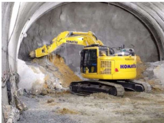
図3 重機による掘削の様子(国交省HPより)
